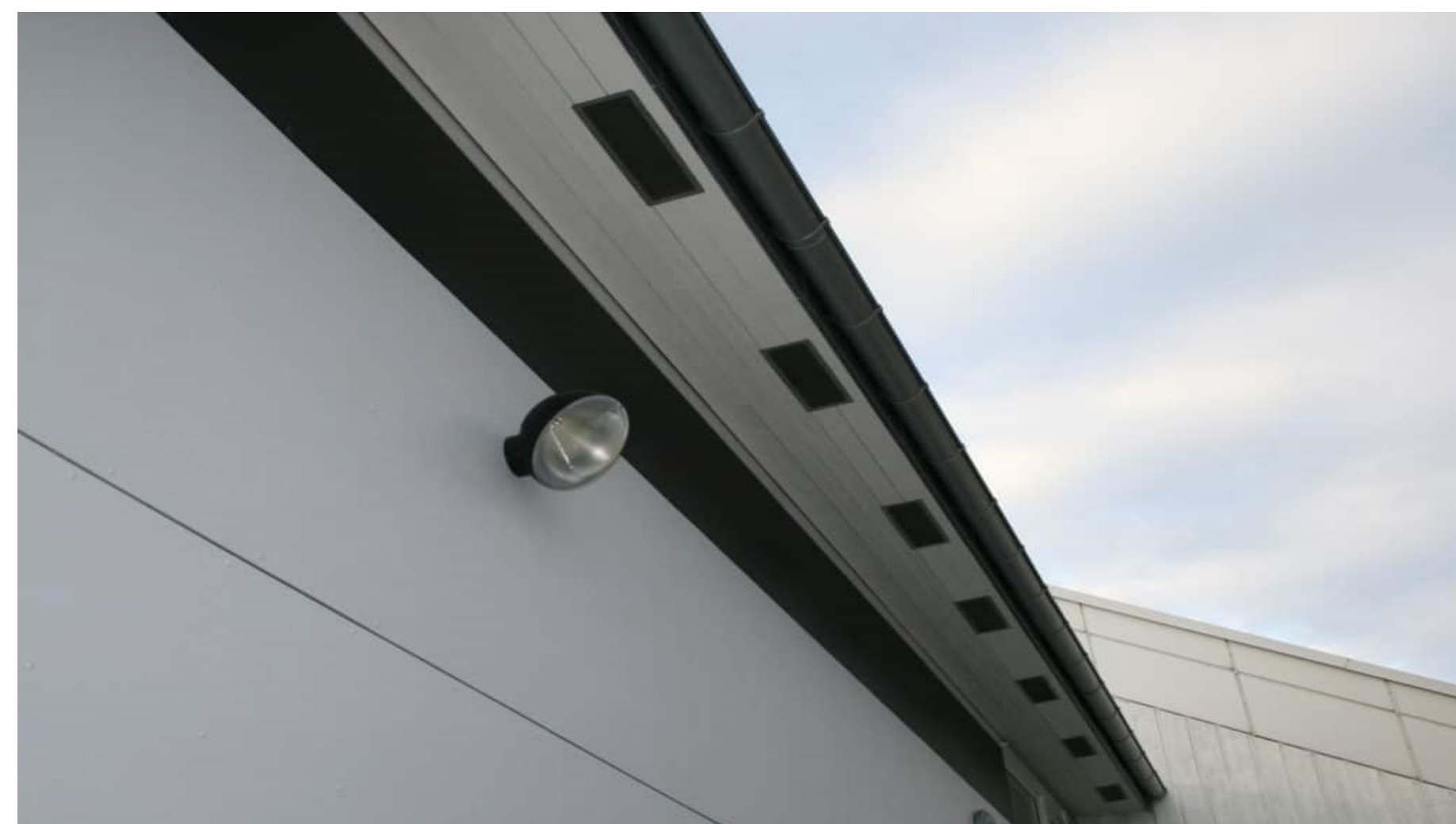
Takfot ventil, den tetter seg ved høy temperatur og slipper ikke igjennom flammer
